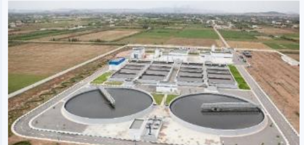
Station d'épuration de Nador
