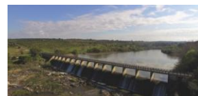
Vanne du Furadouro Hauteur – 14 m Capacité utile – 0,4 hm 3
