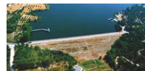
Barrage de Montargil Hauteur – 36 m Capacité utile – 142,7 hm 3
