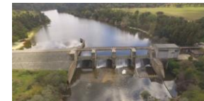
Vanne de Gameiro Hauteur – 16 m Capacité utile – 1,3 hm 3
