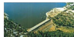
Barrage de Magos Hauteur – 15 m Capacité utile – 3 hm 3
